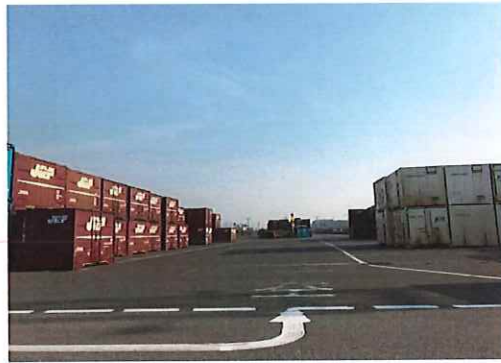
コンテナ発着ホーム
