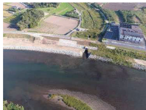
河川改修事業(万之瀬川)
