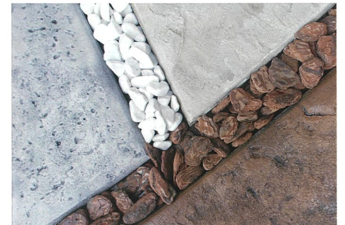
型枠化粧目地
