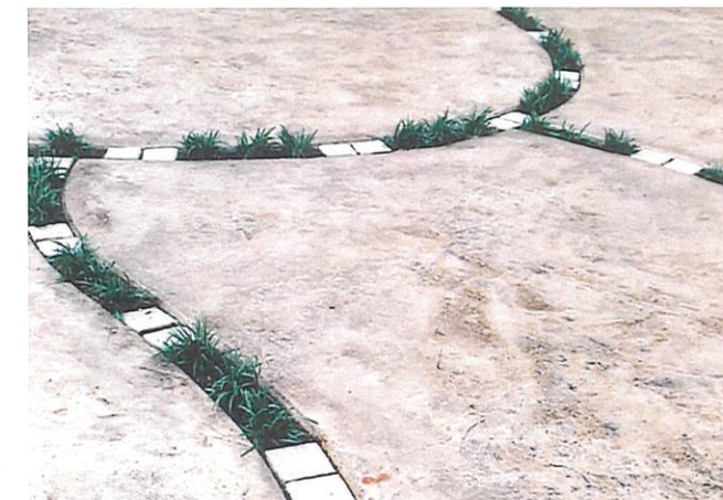
型枠化粧目地
