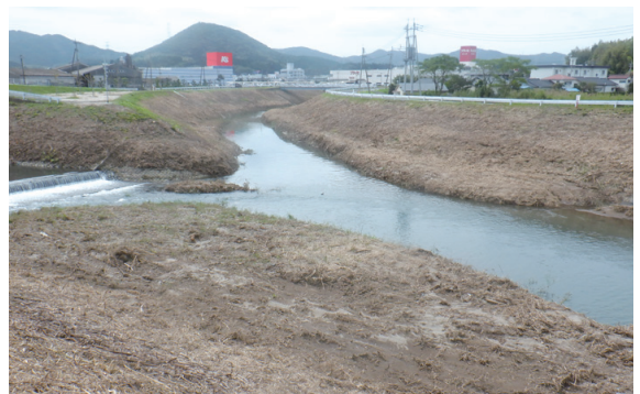
▲各地で要望の多い河川改修、寄洲除去
